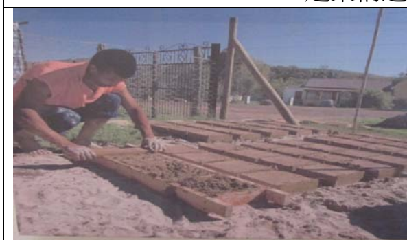
牆壁磚頭以當地泥土製作而成
