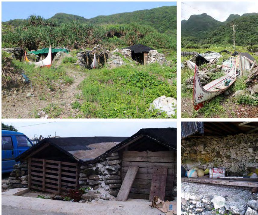
船屋（kamalig）是停放拼板舟的空間，過往也會有人在船屋旁共宿
