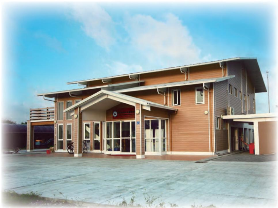
2009年12月完工之東沙管理站
