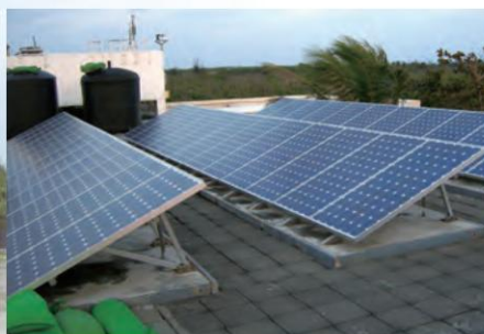
東沙漁民服務站屋頂設置太陽能板
